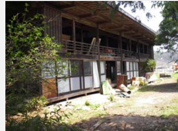
地域古民家再生
