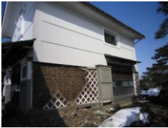
板橋家母屋補修前
