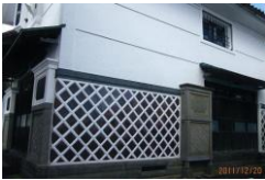
板橋家母屋補修後
